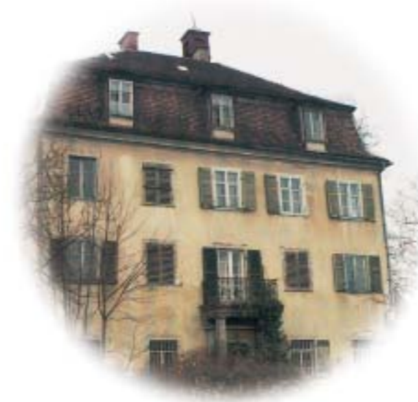
So sah das alte Schloss vor Beginn der Sanierungsmaßnahmen aus.
